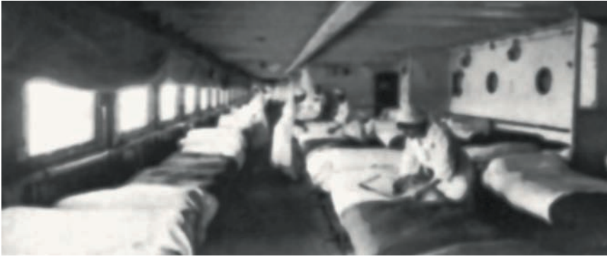
France IV, Galerie intérieure pour malades.
