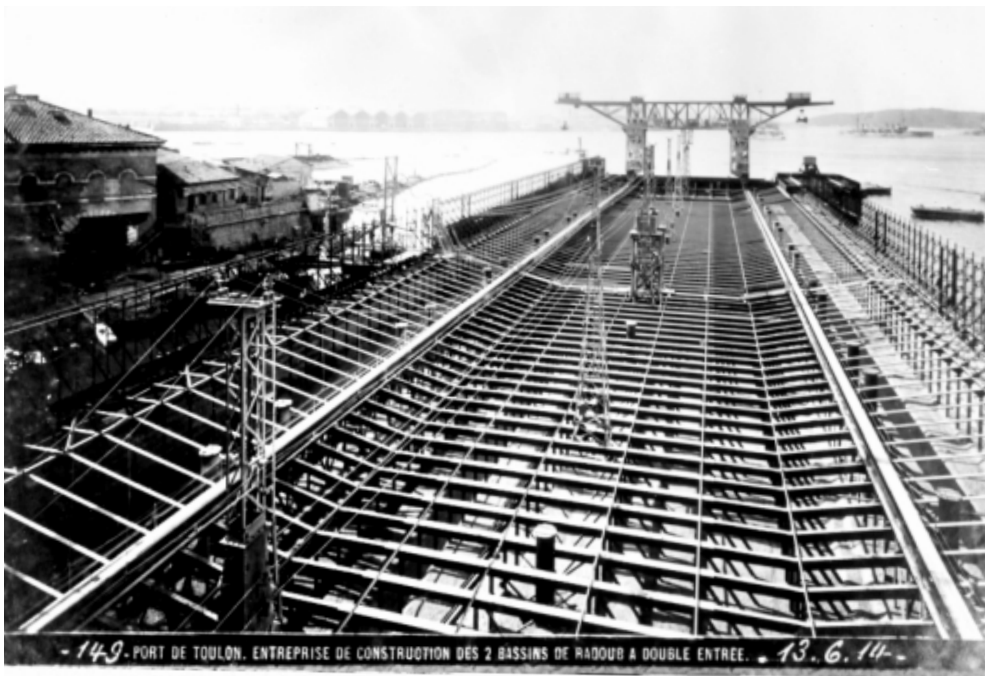
Vue intérieure du caisson métallique
