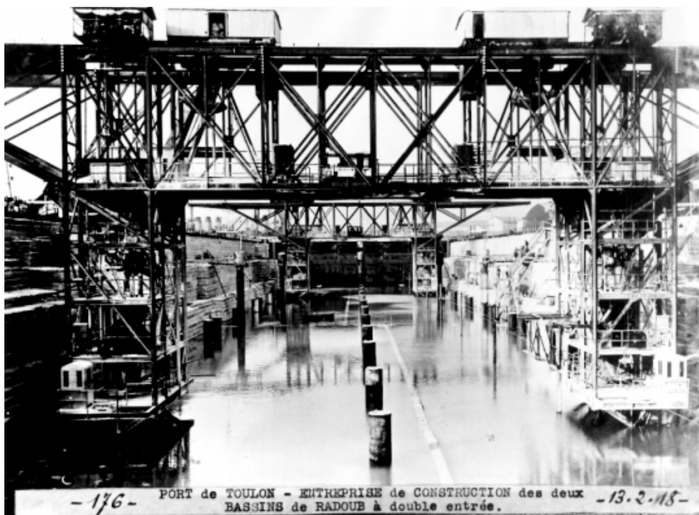
Vue intérieure du caisson métallique : maçonnerie en cours et lestage en eau
