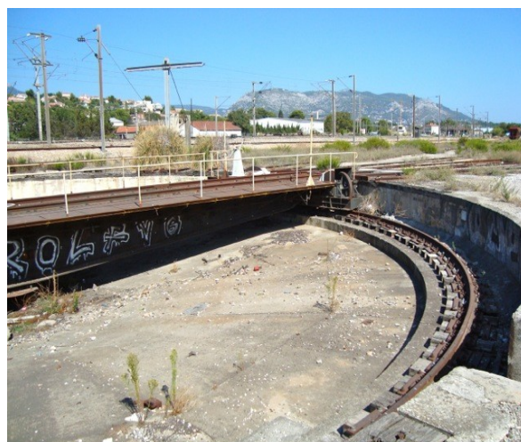
Le pont tournant de la gare SNCF à La Seyne
